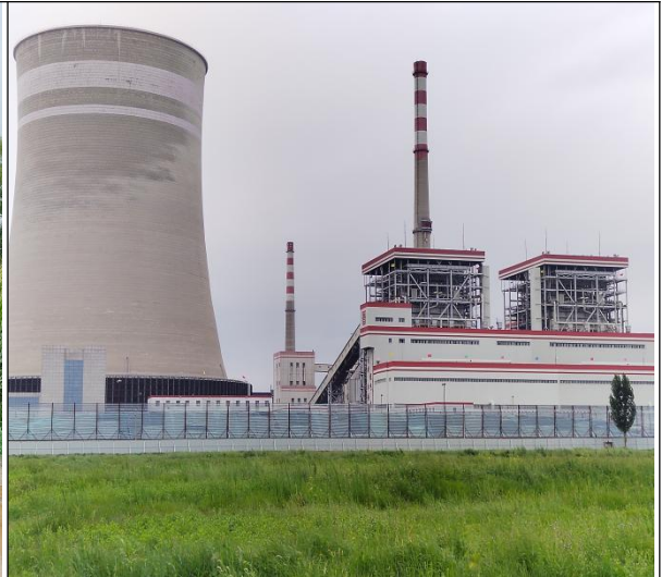
项目西侧（国金电厂）
