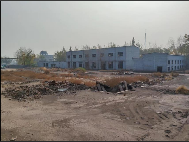
本项目变电站站址现状
