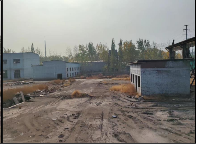
本项目变电站站址现状
