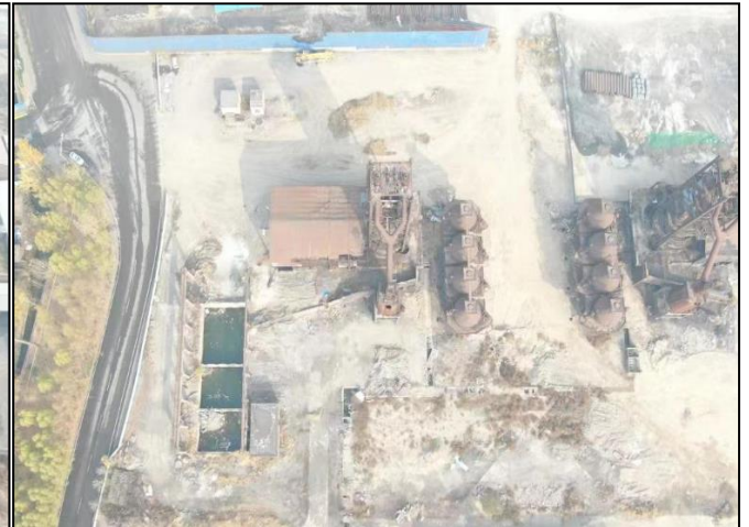
站址现状航拍
